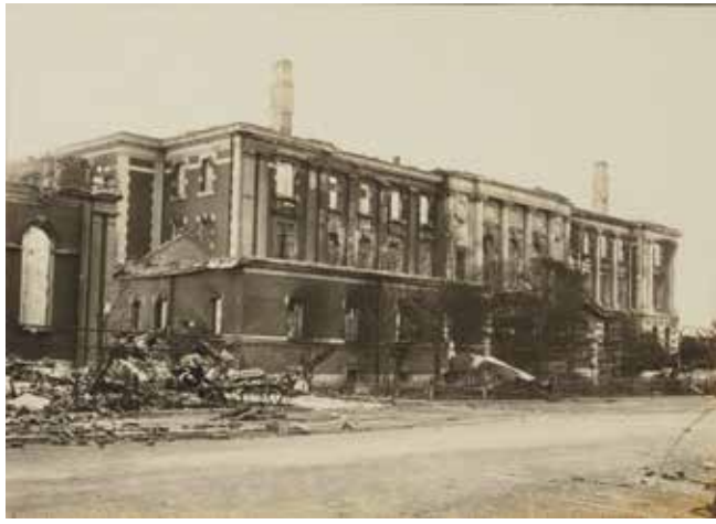
写真 63 震災直後の神奈川県庁（大正 12 年（1923）） （「震災写真帳」のうち）
